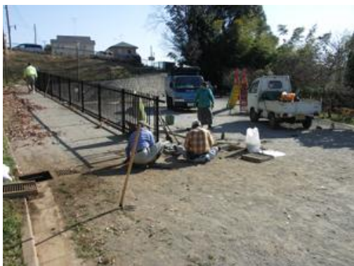
公園雨水排水清掃作業
